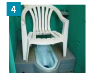
4 仮設トイレの多くは和式タイプ 洋式風にイスをくり抜いて工夫した事例
