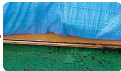
外部への漏れは微小
